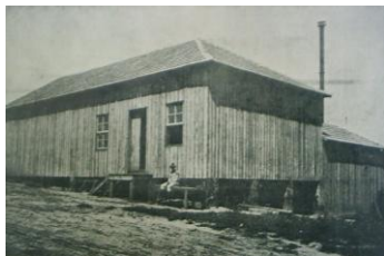
Casa de maquinas.
